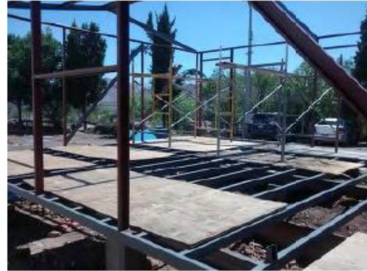
*Proceso constructivo: Estructura de acero y colocación de lámina*
