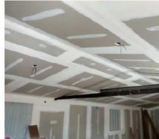
*Proceso constructivo: sándwich de lámina, fibra de vidrio como aislamiento y colocación de tablarroca como acabado interior*
