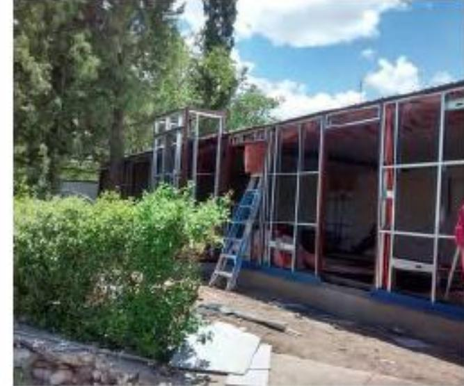
*Proceso constructivo: Aislamiento y construcción de muros a base de lámina con fibra de vidrio*
